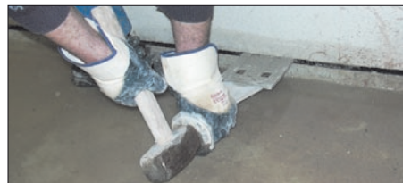
3. Wbijanie klina zapobiegającego osiadaniam ścian
