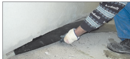
2. Wkładanie płyty izolacyjnej PE-HD
