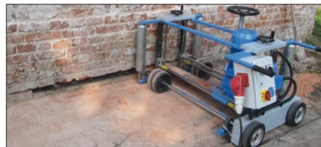
1. Cięcie ściany samojezdną piłą łańcuchową PMS
