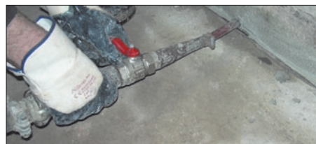
4. Wtłaczanie pod ciśnieniem zaprawy cementowej
